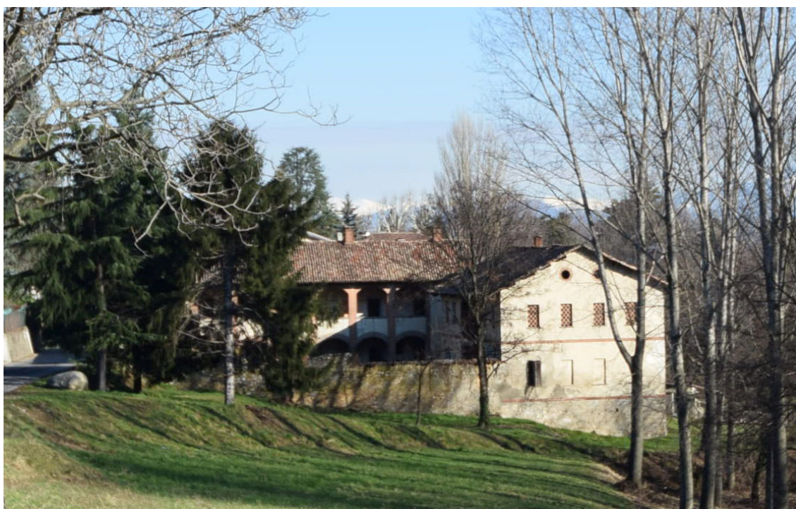
RILIEVO FOTOGRAFICO FRONTE SUD
